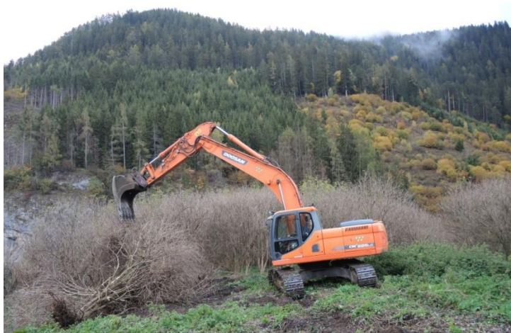
Abb. 16: Schurf A: Rodung der Deponieoberfläche vor dem Ausheben
