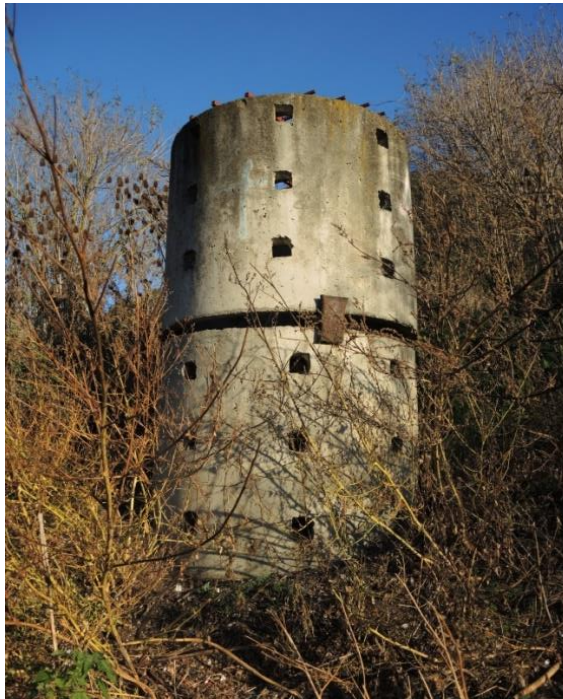
Abb. 12: Gasschacht Nr. 4 mit erkennbarer Setzung des Deponiekörpers
